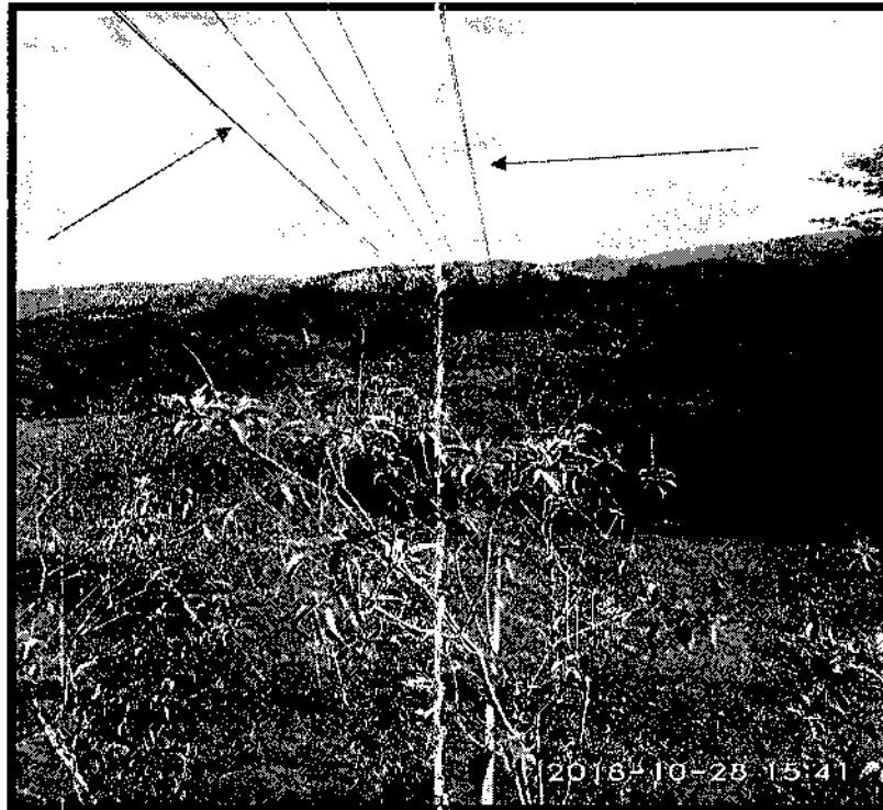
CONTINUACION SERVIDUMBRE ELECTRICA CARGA 34,5 KV
