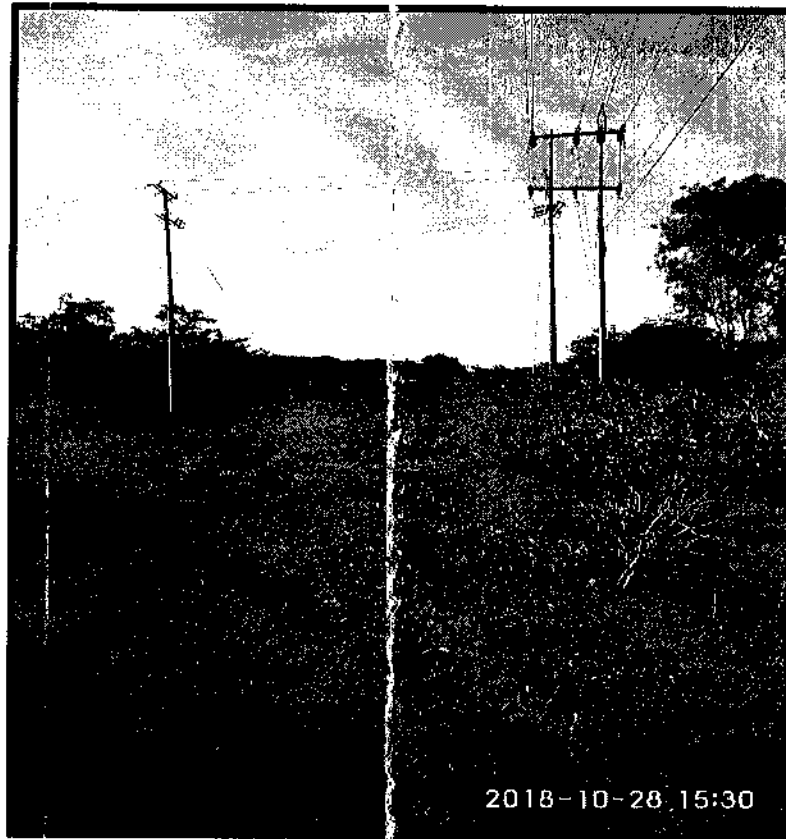
VISTA POSTES -SERVIDUMBRE ELECTRICA
